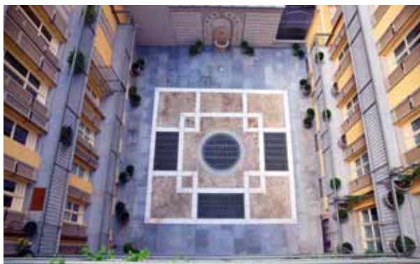
Vista dall'alto della corte interna di Palazzo Barbaroux dopo i lavori di restauro
